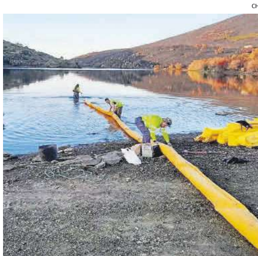
Instalación de barreras en el embalse de Serradilla.
